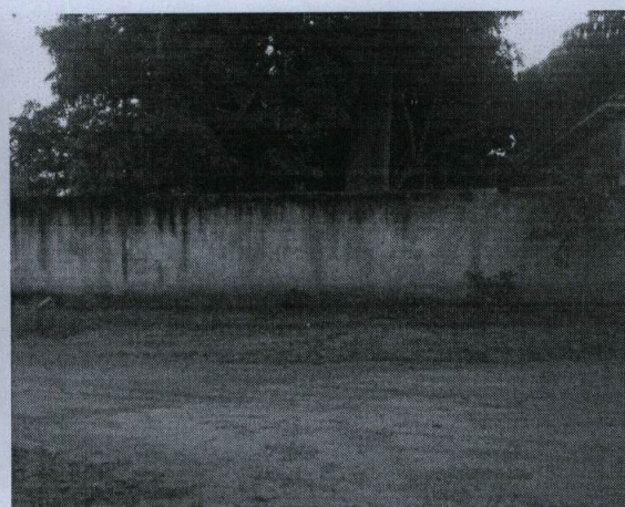
VISTA DO MURO COM DIVISA DA UFT
