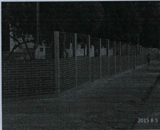
VISTA DO MURO FRONTAL CONCLUÍDO
