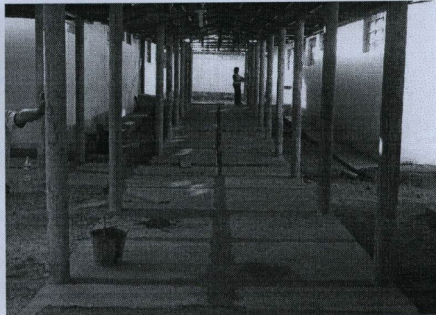
Passarela – Cobertura metálica executada
