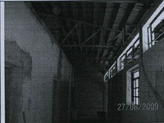
Bloco das Salas de Aula – Cobertura metálica executada
