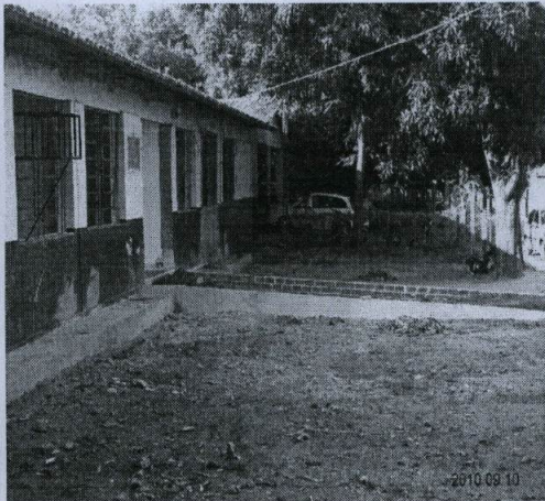
Bloco IV – Cobertura metálica executada
