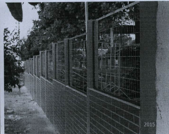
VISTA DO MURO FRONTAL CONCLUÍDO
