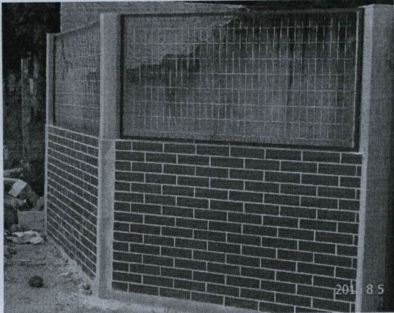
VISTA DO MURO LATERAL
